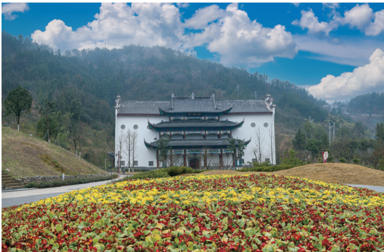
曾经的高尖铺现在的数智森林小镇数据中心
